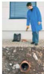
Seguimiento de cables subterráneos (profundidad máxima de 2,5 m)
